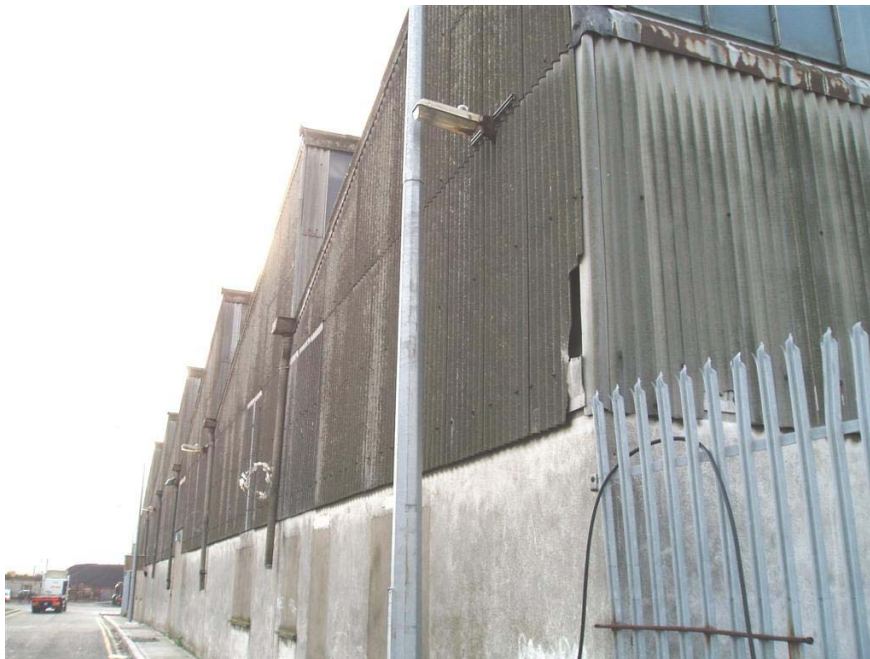
Abb. 4.10 Verkleidung aus Asbestzement an einer Fabrik
