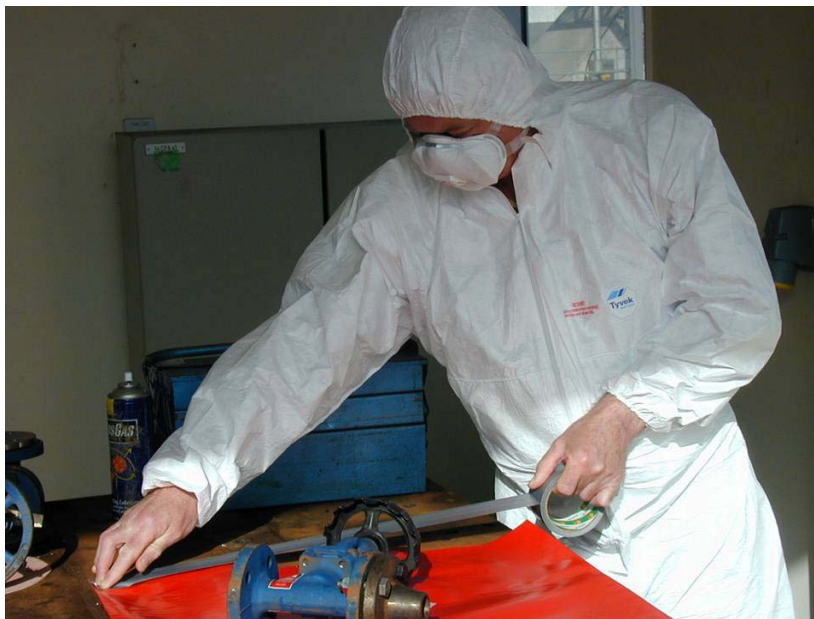
Abb. 11.3 Verwendung von Klebeband und Polyäthylenfolie, um einen Arbeitsbereich abzudecken, bevor Asbestdichtungsmaterial von einem Ventil entfernt wird.
