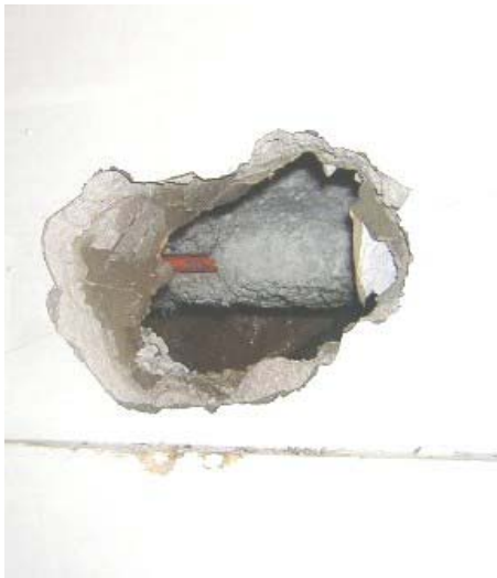
Abb. 4.4 Loch in der Wand enthüllt Rohrisolierung aus Asbest
