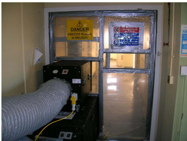
Abb. 12.2 Unterdruckeinheiten und Luftablassröhren, Sichtfenster und Warnhinweise
