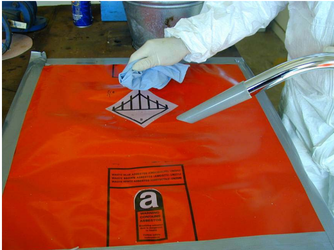
Abb. 11.7 Sorgfältige Reinigung des Arbeitsbereichs mit einem H-Typ Staubsauger und einem nassen Lappen
